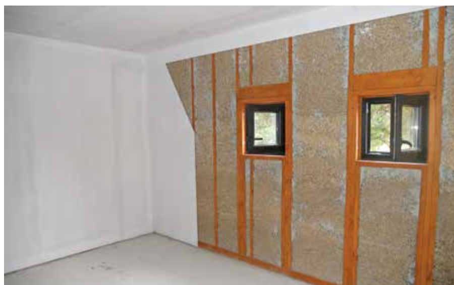
◆ Fot. 3. Wnętrze budynku wykonanego w technologii kompozytu wapienno-paździerzowego (J. Kołodziej)
