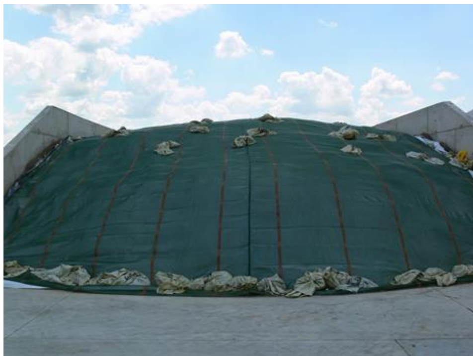
Fotografia 6. Sposób przykrycia kieszonki w silosie przejazdowym
