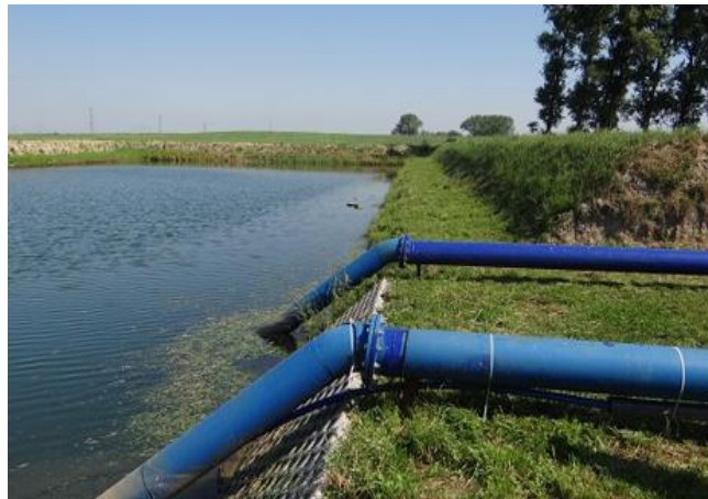
Ujęcie wody powierzchniowej ze sztucznego zbiornika z systemem pomp i filtrów (lewy), sonda z transmisją danych do pomiaru wilgotności (prawy)
