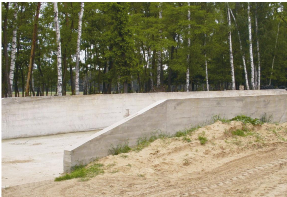
Fotografia 4. Silos przejazdowy bezpośrednio po wybudowaniu
