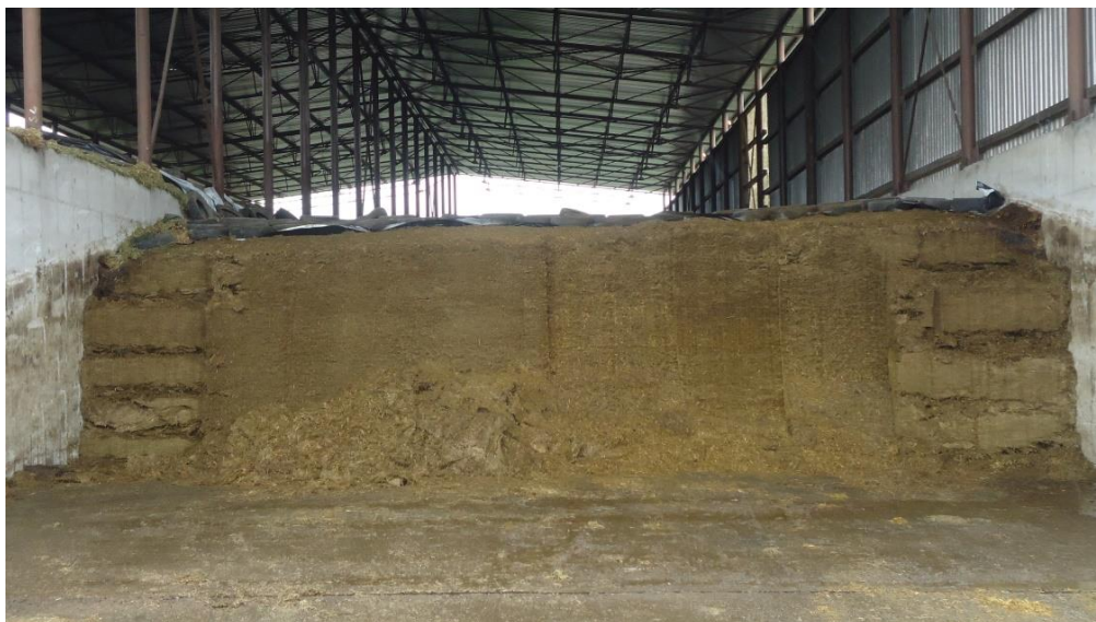
Fotografia 7. Silos przejazdowy zadaszony ułatwia osiągnięcie najwyższej jakości kiszonki oraz minimalizację strat
