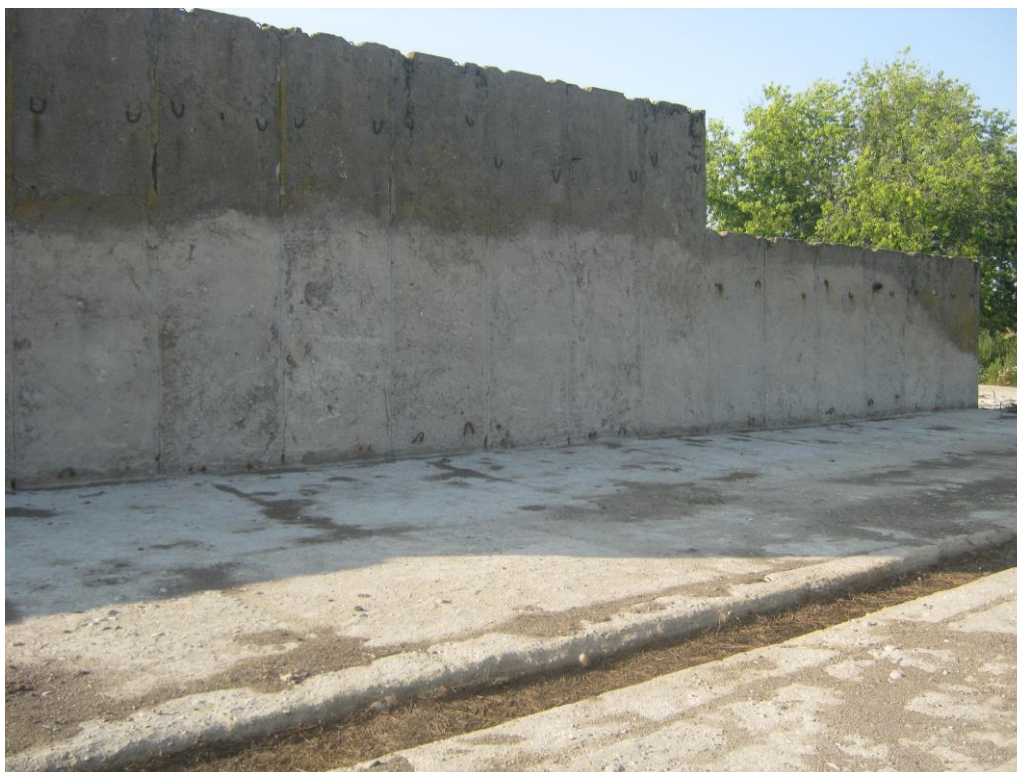
Fotografia 3. Silos betonowy do przechowywania kiszonek
